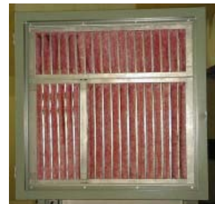
Kuva 9. Erilliskehys ja pussien taitosten oikea suunta.
